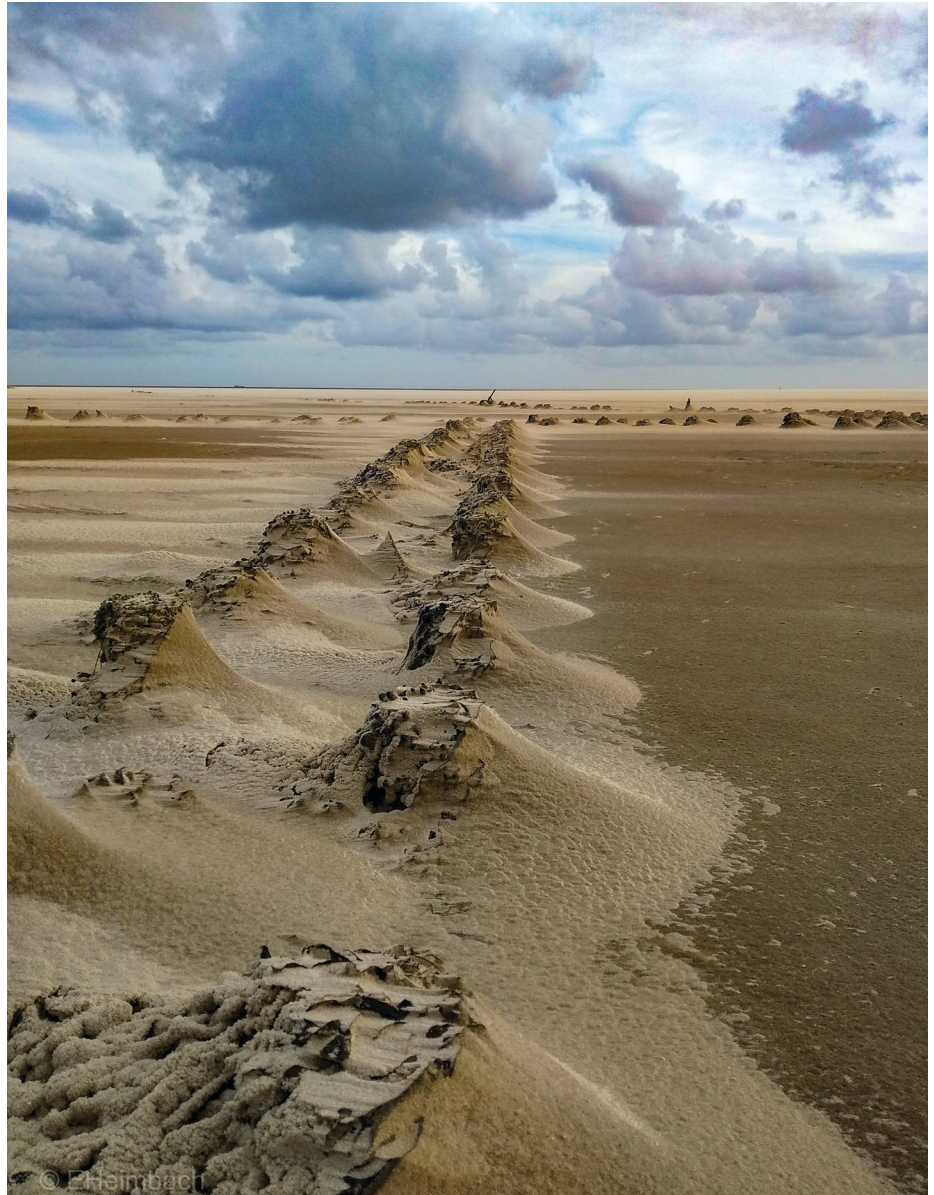
Die Bühnen an der Westkante von Hallig Norderoog werden bereits vom Norderoogsand begraben. Foto: Elisabeth Heimbach
