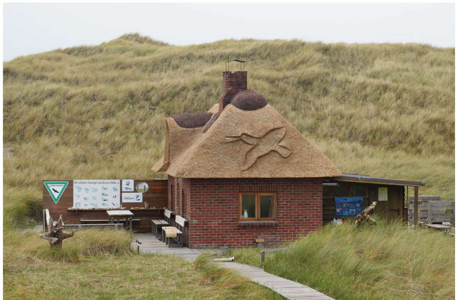
Das neue Reetdach mit einem besonderen Hingucker.
