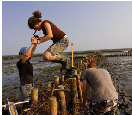
Lahnungsbau erfordert vollen Körpereinsatz! Foto: Sebastian Conradt
