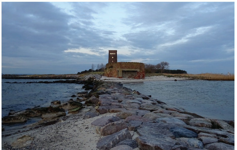
Blick von der Südmole auf den Beobachtungsturm.
