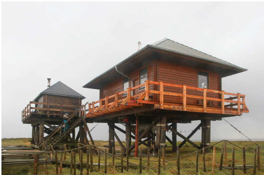
Der neue Umlauf an der großen Vogelwärterhütte.
