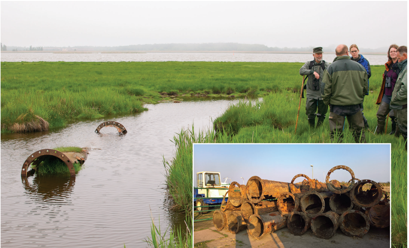
An freigespülten verrosteten Rohrdurchlässen verletzten sich jedes Jahr Rinder. Diese Altlasten konnten im August 2016 von einer Fachfirma geborgen und entsorgt werden (kleines Foto). Fotos: NPA Vorpommern; H. Renker
