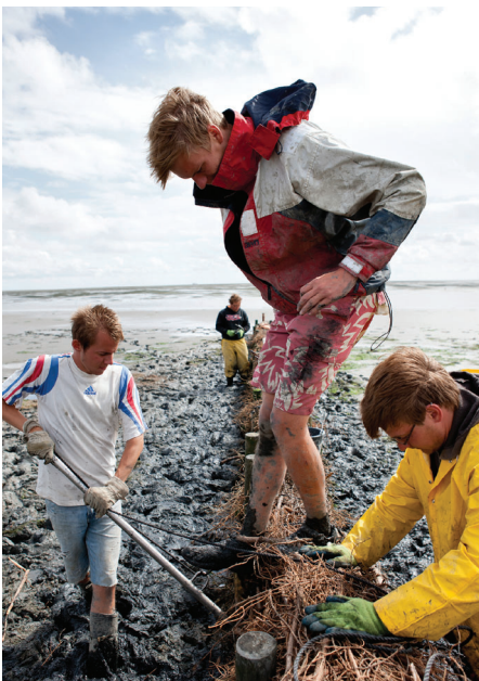
Lahnungsbau zum Schutz der Hallig Norderoog. Foto: Gregor Eisele
